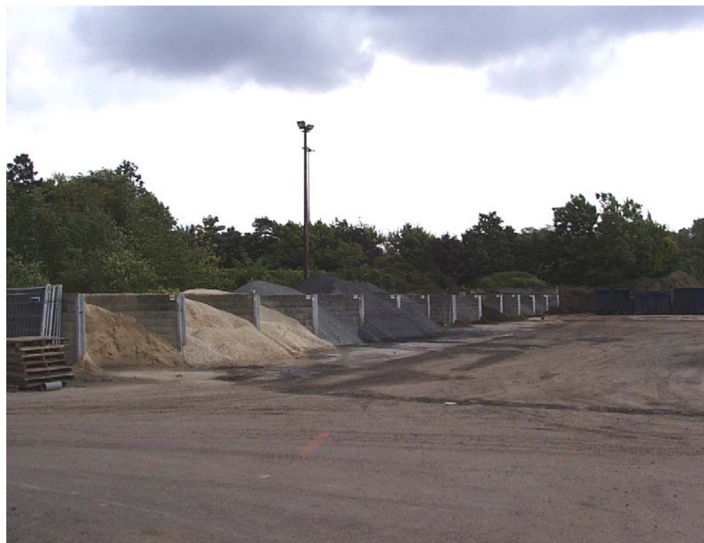
Zicht op de betonnen stapelbakken voor materialen in kader van de tuinaanneming
